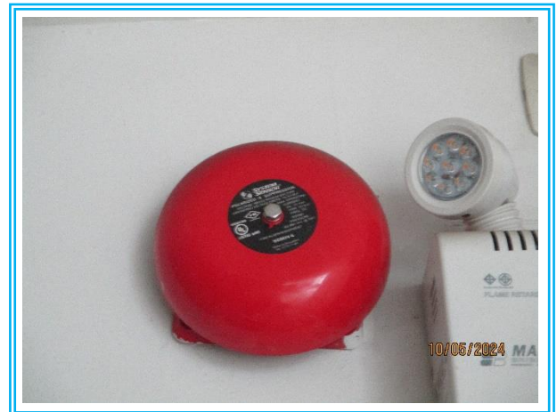
รูปที่ 2.5-11 อุปกรณ์ส่งเสียงสัญญาณแจ้งเหตุอัคคีภัย
